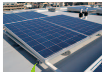
⑥太陽光パネルの設置
