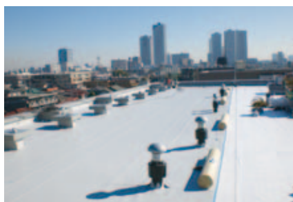
②絶縁シート敷設後、リベットルーフ敷設
