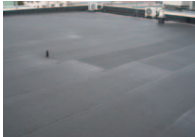
改修前：露出アスファルト防水
