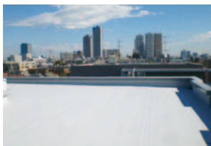
③リベットルーフ防水完了
