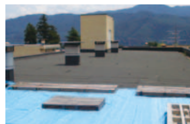
既存防水:露出アスファルト防水
