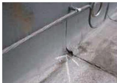
防水層の亀裂・口開き (改修前)
