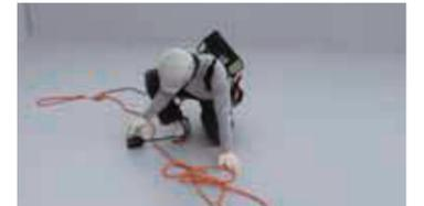
誘導加熱によるリベットルーフ防水の接合
