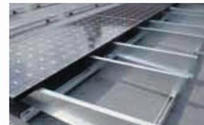
太陽光パネル(1段目)を傾斜付き架台に取付ける
