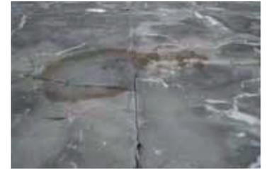
● 露出防水層の破断
