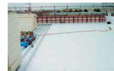
施工中(デッキプレートに断熱材設置)
