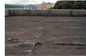
● 押えコンクリートの目地の飛び出し
