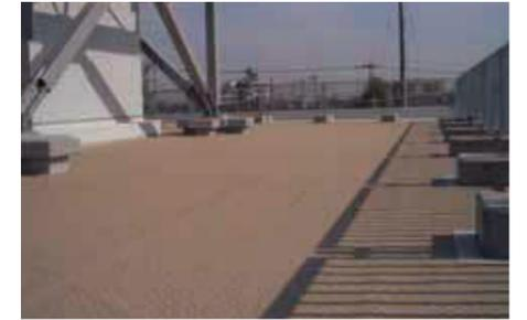
歩行部分には、圧縮強度の大きい断熱材を組み合わせる
