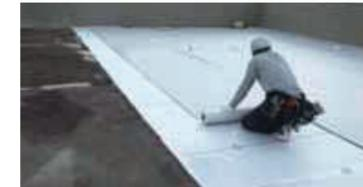
専用ディスク固定後、リベットルーフ防水の敷設
