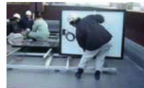
太陽光パネル(2段目)を傾斜付き架台に取付ける
