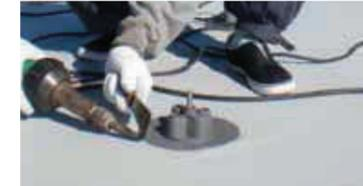
軽量架台「連結ディスク」の固定
