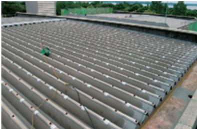
補強鋼板の設置
