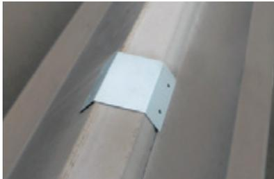
IHディスク固定部分にブラケット(補強鋼板)を設置
