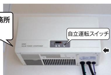
事務所1箇所あたり、パワーコンディショナーを2つずつ設置しているため、合計3.0kVAの電源供給が可能。停電状態では、本パワーコンディショナーが、電力システムの負荷に電力を供給します。
