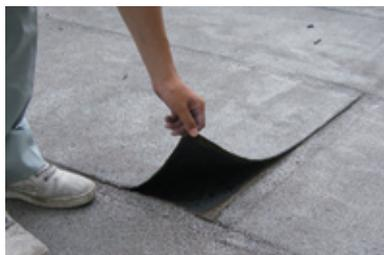
改修前(アスファルト防水の剥離)
