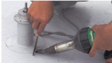
制振装置周囲を防水処理
