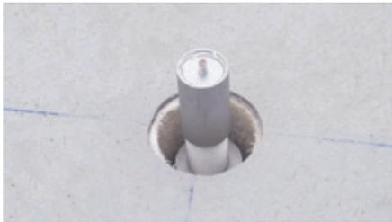
リベットルーフ・既存防水層・既存断熱材をくりぬき、連結ディスク、アジャスターを設置。隙間には発泡断熱材を充填
