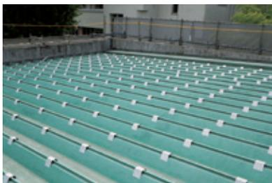
補強鋼板設置
