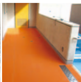
改修後:更衣室付近
