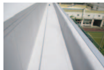
改修後:軒先部
