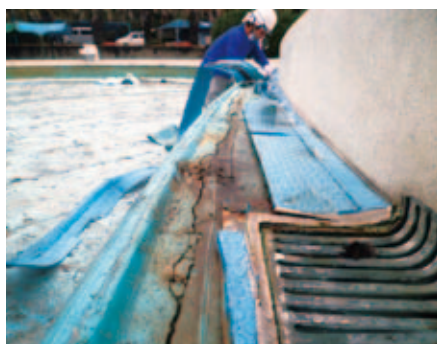
改修途中:手掛け部
