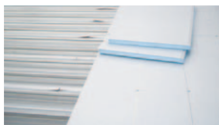
FLボードMS敷設
