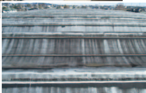
改修前：屋根面
