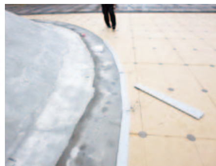
取り付け部にはFL鋼板(特注)を設置。
