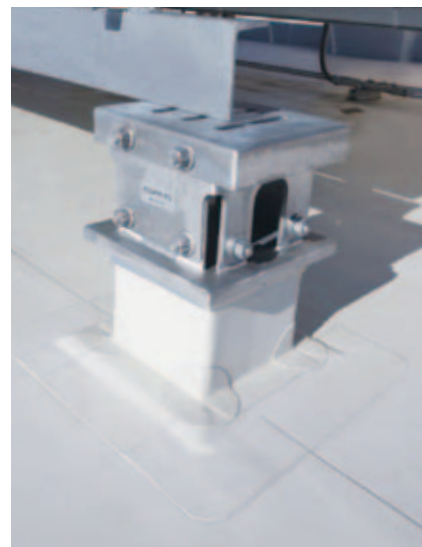
グリッドベースL設置部。アンカーで保護コンクリート層に対して固定。(右ページ参照)
