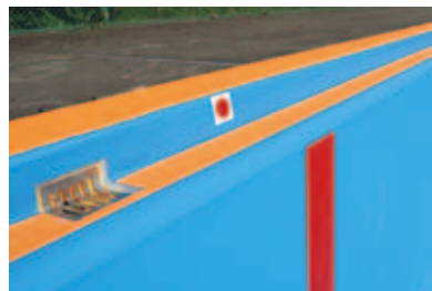
犬走りに転倒防止用にコリドールを増し張り。
