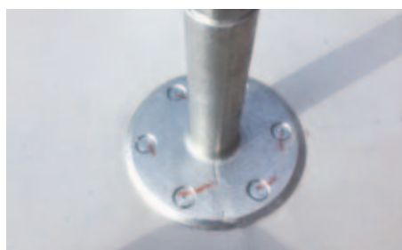
防水改修後にグリッドベースMを設置、固定。
