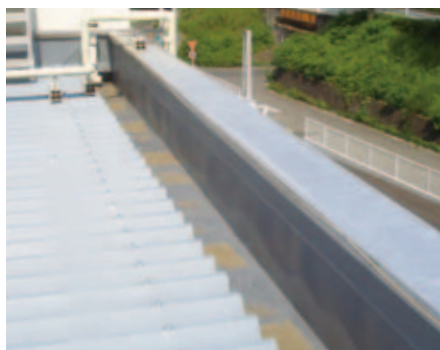
改修前:内樋部
