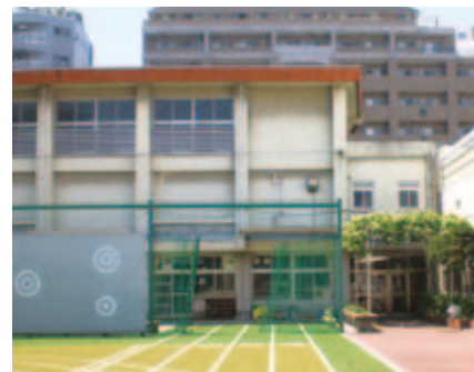
防水改修前の体育館外観。約900㎡を施工しました。
