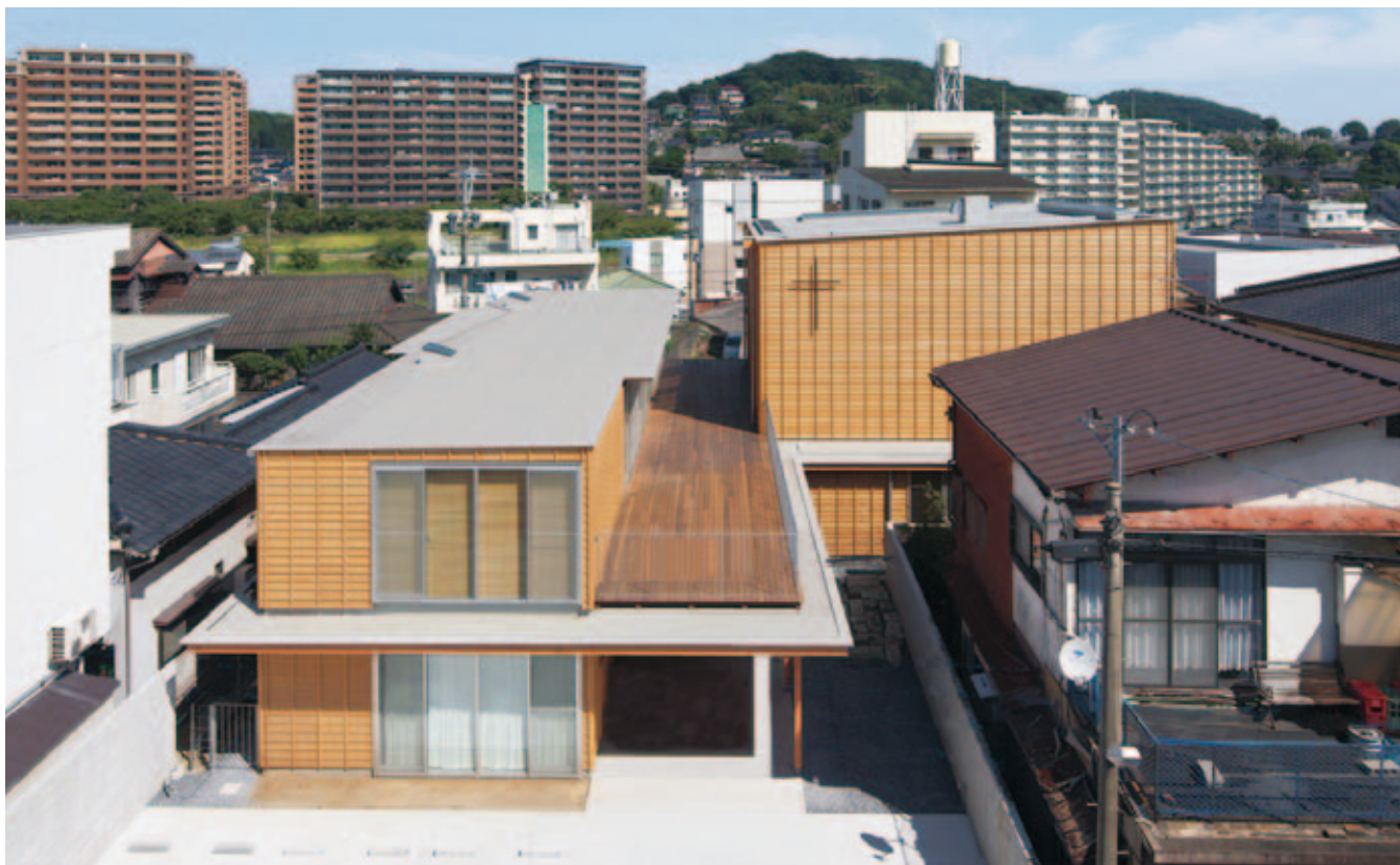
建物の上部から撮影された写真：2階の屋根部分、ウッドデッキが配された軒の部分にリベトルーフ防水システムが採用されている。
