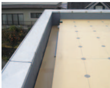
改修中:内樋部
