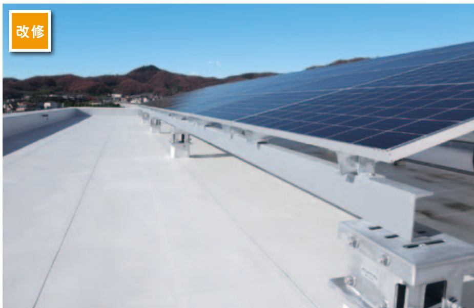
グリッドベースL設置部。アンカーで保護コンクリート層に対して固定。(右ページ参照)
