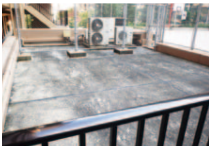
改修前:スポーツガーデン
