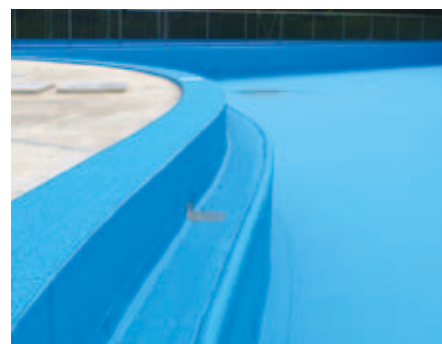
改修後:手掛け部
