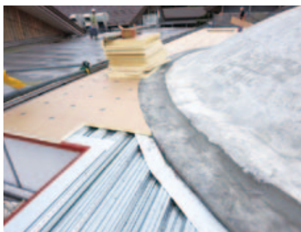
断熱材敷設後、IHディスクの固定。
