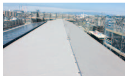
リベットルーフ施工完了。
