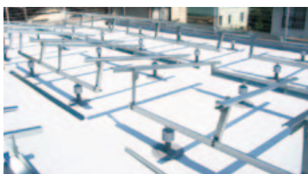
防水改修後、グリッドベースMと架台を設置した状況。
