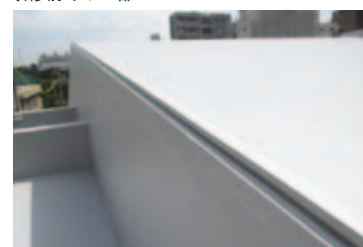
改修後:ケラバ部
