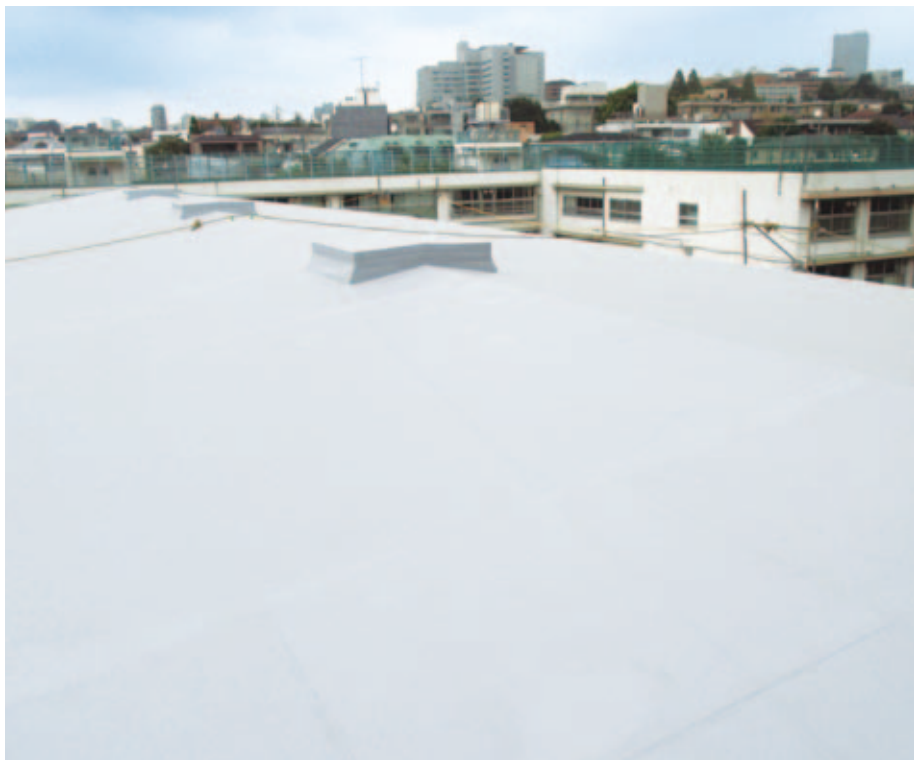
防水改修後の瓦棒屋根。採用された防水シートは「リベットルーフSW」の1.5mm。
