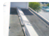
改修前の4階屋上部分。
