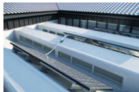
モジュール設置部を裏側から見た状況。
