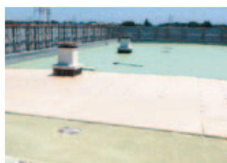
既存防水層を撤去せず、防湿シートと断熱材を敷設。
