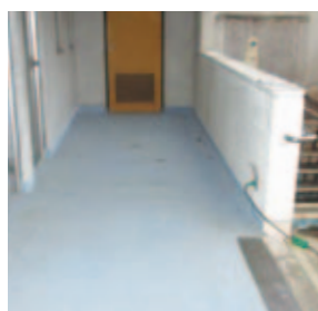
改修前:更衣室付近
