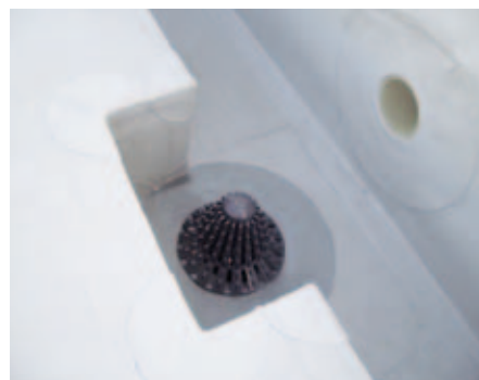
改修後:ドレン部(特注オーバーフロー設置)
