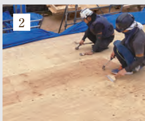
2 野地板張り。ケレン清掃。
