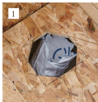
1 ドレン設置部分の施工前の状態。
