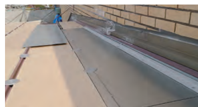
瓦棒屋根と壁面の取り合いには補強用鋼板を設置。
