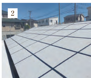
2 目地部にALジョイントテープ貼り。
