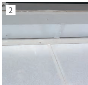
FLボードMS接合部にAYボードテープを貼り付け。入隅部FL鋼板の固定。
