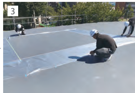
3 外周部を養生する。
