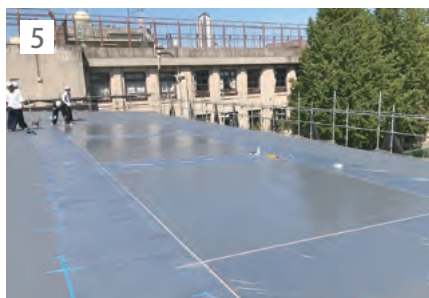
5 塗布完了。2時間乾燥する(20℃の場合)。
