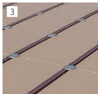
補強ブラケットにIHディスクを固定。
