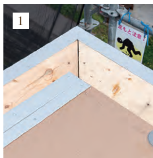
FL鋼板の固定。
