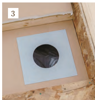
3 ドレン設置部の穴あけ完了。
