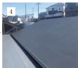
4 リベットルーフの敷設・転圧。シート相互を溶融着して完成。
