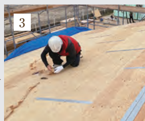
3 目地部ALジョイントテープ貼り。
