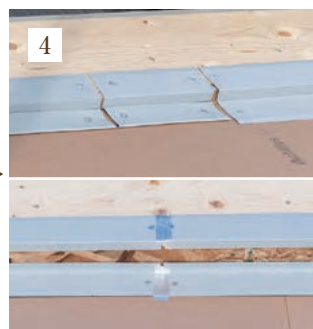
FL鋼板の設置。FLアルミテープ貼り。
