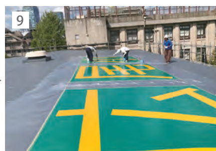
9 クリアーコートの塗布。48時間以上乾燥させる。
