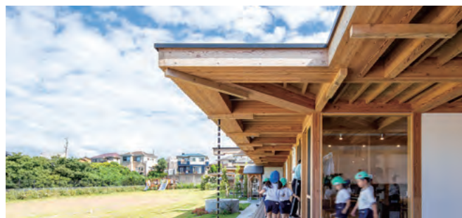
2メートル迫り出した軒先。端末にはFL鋼板ブラックを採用している。
