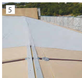
リベットルーフを敷設し、FL鋼板と溶着接合。
