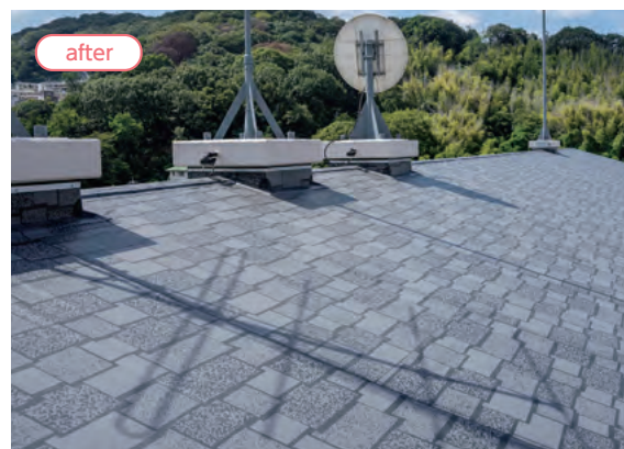
アンテナ基礎部分も「アルトシート」で改修。
