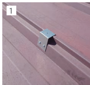
補強ブラケットの取付け。
