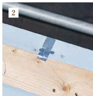
FLアルミテープ貼り。
