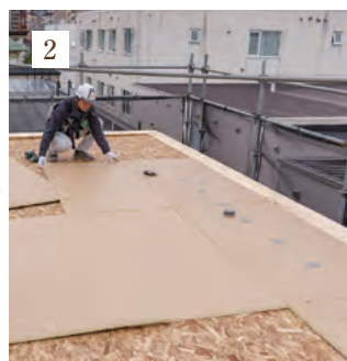
断熱材を水上から敷設していく。
