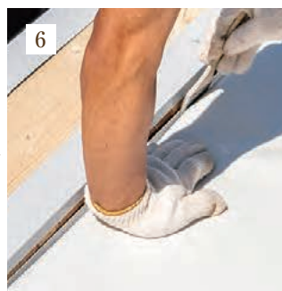
パラペット入隅部に溶着。
