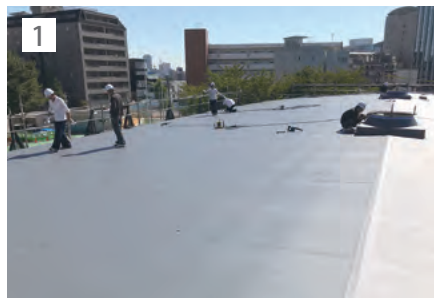
1 LCS-R工法で防水改修工事を完了。 ヘリサインの施工をスタート。
