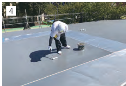
4 AYプライマーReの塗布。
