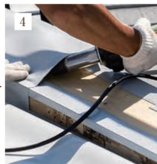
パラペット部のFL鋼板へ熱融着する。
