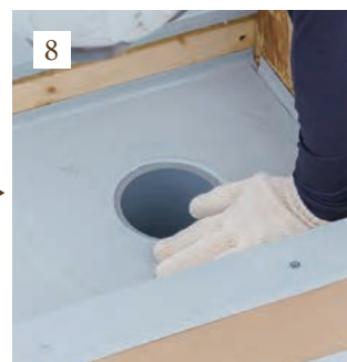
8 転圧して完成。
