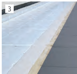
AYボンド580NFを塗布し、リベットルー HPを貼り込み。
