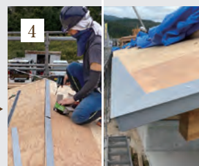
4 FL鋼板の設置・端水切り金物の設置。
