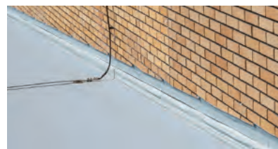
屋根と壁面部の取り合い。
