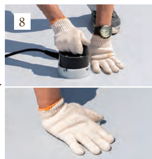
誘導加熱接合後、シリコンパッドで押さえて圧着。
