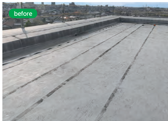
アンカー固定工法で施工された既存防水層。
