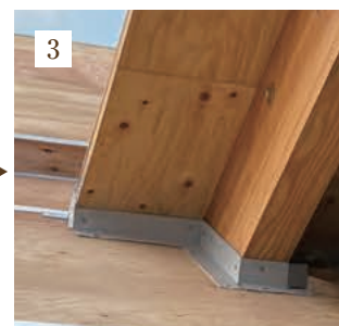
FL鋼板の固定。
