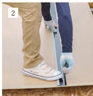
2 内樋の幅に合わせて断熱材をカット、敷設。
