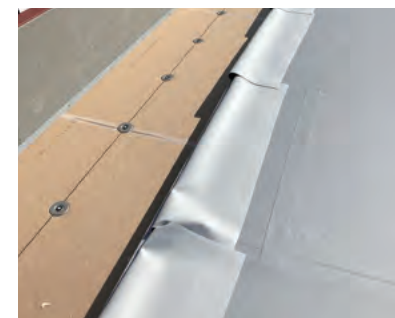
絶縁シート機能付き断熱材FLボードNUを使用。
