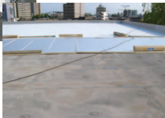
手前が改修前のシート防水、その奥が断熱材を敷設しているところ
