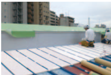
一層目断熱材の敷設
