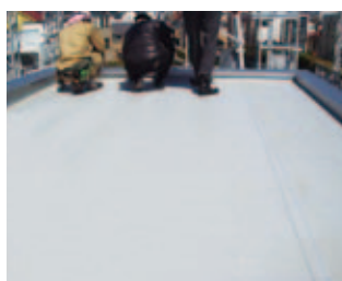
1.リベットルーフ施工完了後
