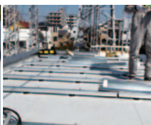
3.連結レールを固定
