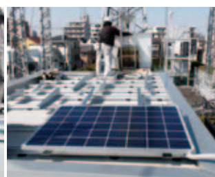
4.太陽光モジュールを設置
