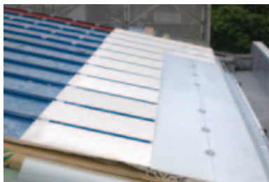
二層目断熱材の敷設
