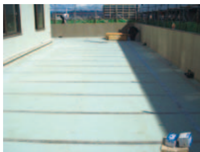
FLボードNP相互は長手・短手とも耐火のためアルミテープでジョイント処理
