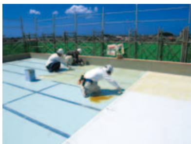
リベットルーフは接着工法で固定
