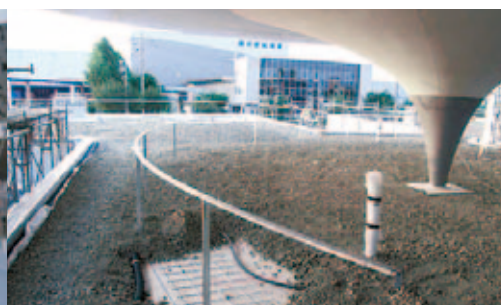
軽量土壌敷設
