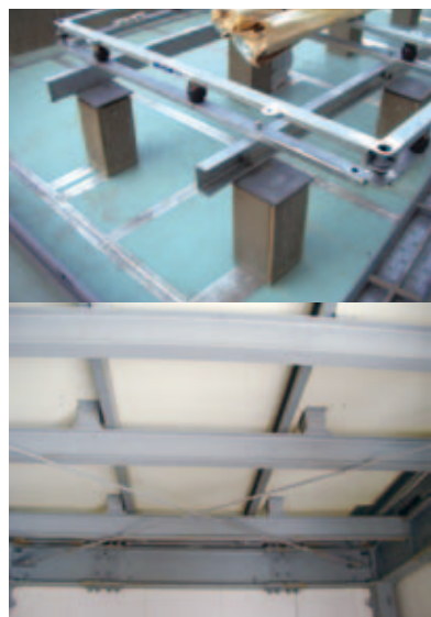
FLボードNPを貫通させて架台基礎を出している。
