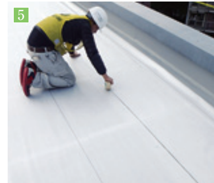
絶縁シート敷設。PPジョイントテープ貼付け。
