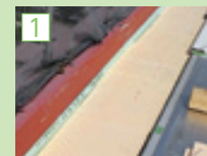
断熱材の敷設。
