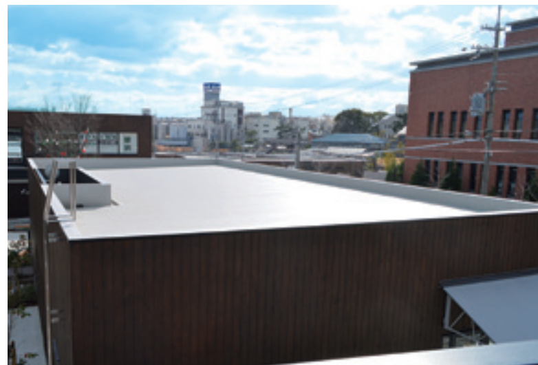
商業施設東側に位置する棟の屋上。
