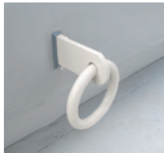
丸環部の施工後。
