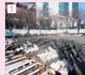
既存の階段などを撤去し清掃を実施。
