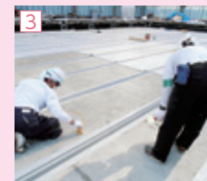
リベットルーフ防水を接着工法で施工。
