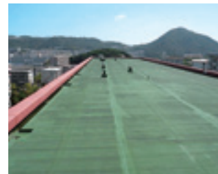
改修前の屋上。
