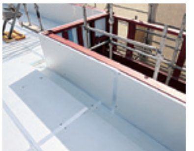
立上り部にもFLボードMSが採用されています。
