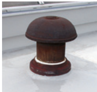
臭気筒部分の施工後。
