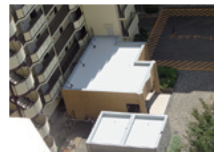
改修後の共用玄関部。
