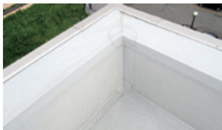
立上り部の施工後。
