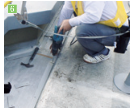
FL鋼板の取付け。
