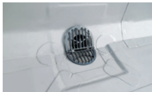
横型ドレン部の施工後。
