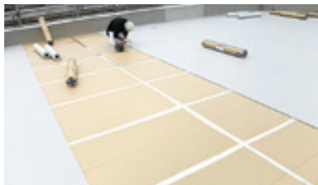
リベットルーフSWの敷き込み。
