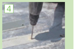
FL銅板の設置・固定。
