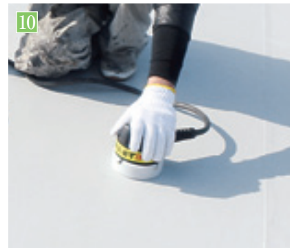
IHディスクの誘導加熱接合。
