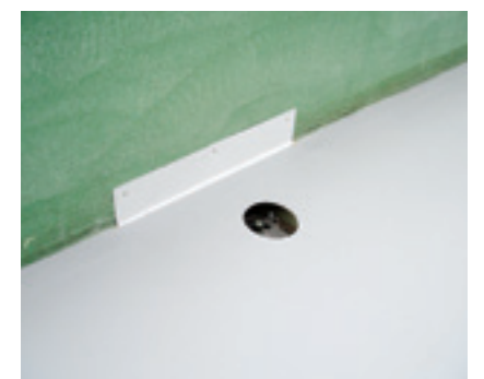
縦型ドレン設置部は、ドレン鋼板を折り曲げて設置・固定。この後、立上り面にリベットルーフを施工。
