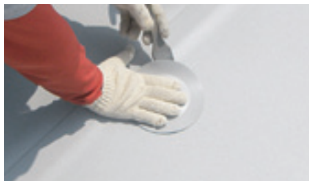
FLディスクの設置・固定後、ディスクパッチを溶着。
