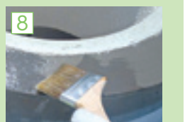
役物などへのウレタン塗膜防水施工。
