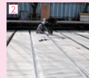
溝などにFL鋼板を設置・固定。
