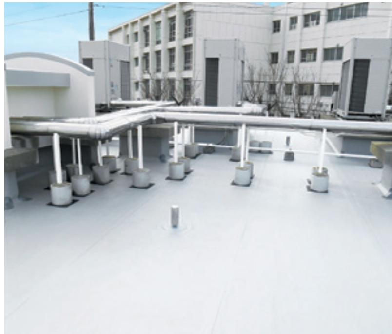
基礎設置部の改修後。
