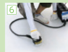
IHディスクの誘導加熱接合。
