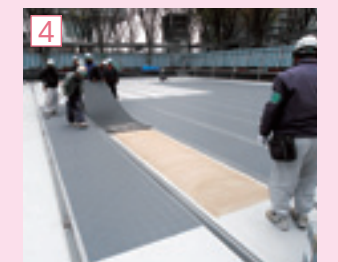
コリドールを接着工法で施工。
