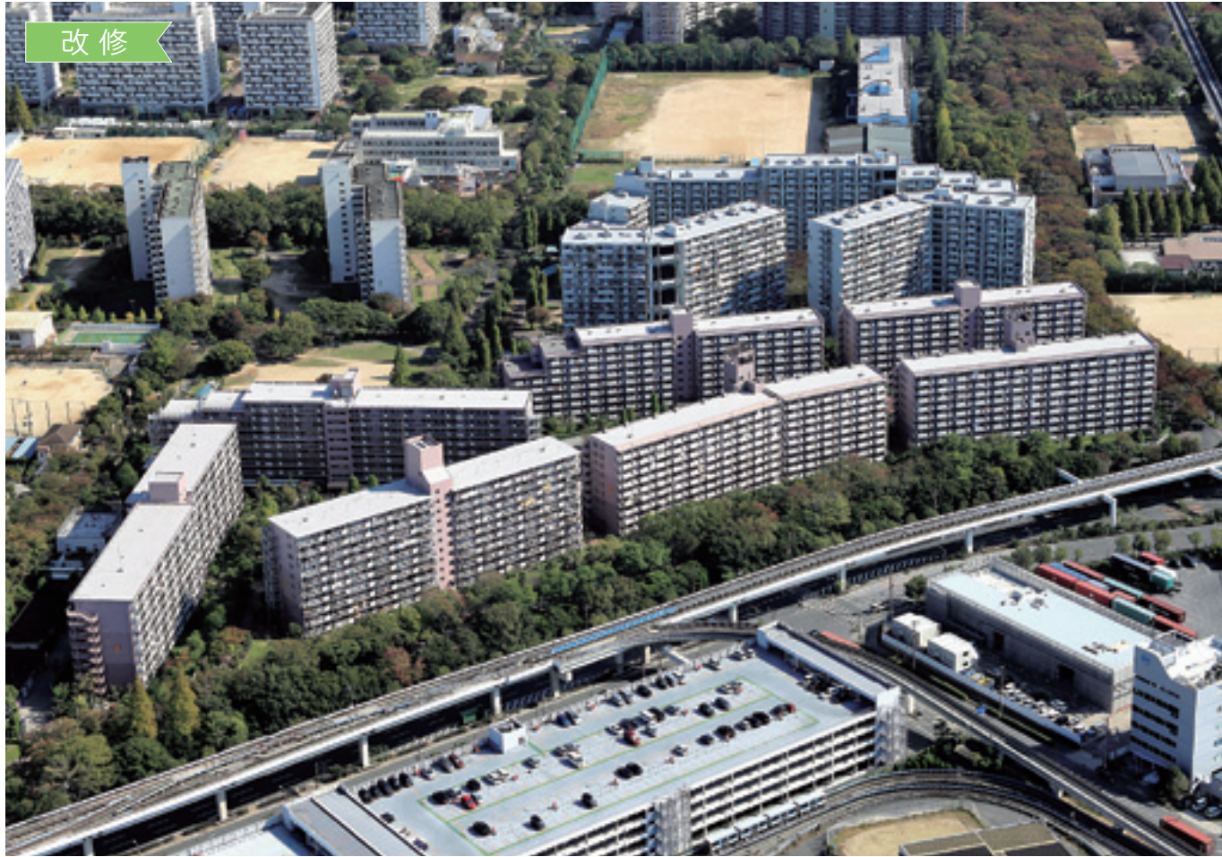
上空から見た施工物件。 リベットルーフSGMを用いたアンカー固定工法で防水改修を実施しています。
