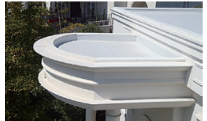
改修後のひさし部。
