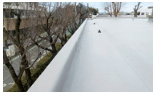
アンカー固定工法が採用されたパラペット部。
