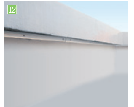
押入金物取付け。完成。
