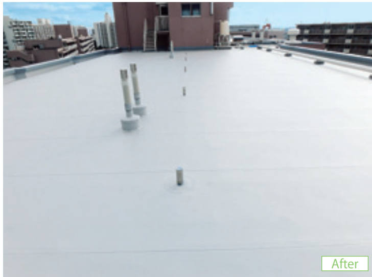
上空から見た施工物件。 リベットルーフSGMを用いたアンカー固定工法で防水改修を実施しています。
