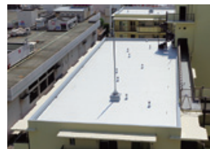
改修後のD棟屋上部。
