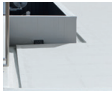
商業施設東側に位置する棟の屋上。 雨仕舞いについて適切な配慮がなされており、しっかり とした勾配が確保され、側溝を設けた上で、LCSドレン 横型が設置されています。
