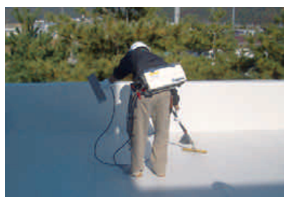
探傷検査を行っている様子。
