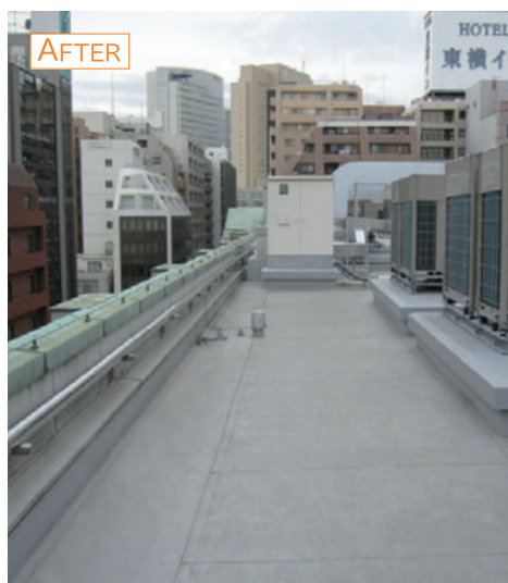
施工後の屋上
