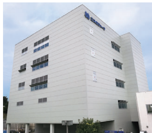
品質管理業務を行う施設の外観。
