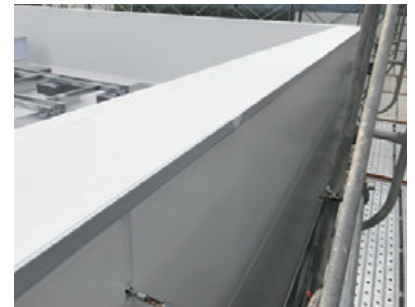
立上り部（施工後）。防水シートの施工後、アルミ笠木が取り付けられています。
