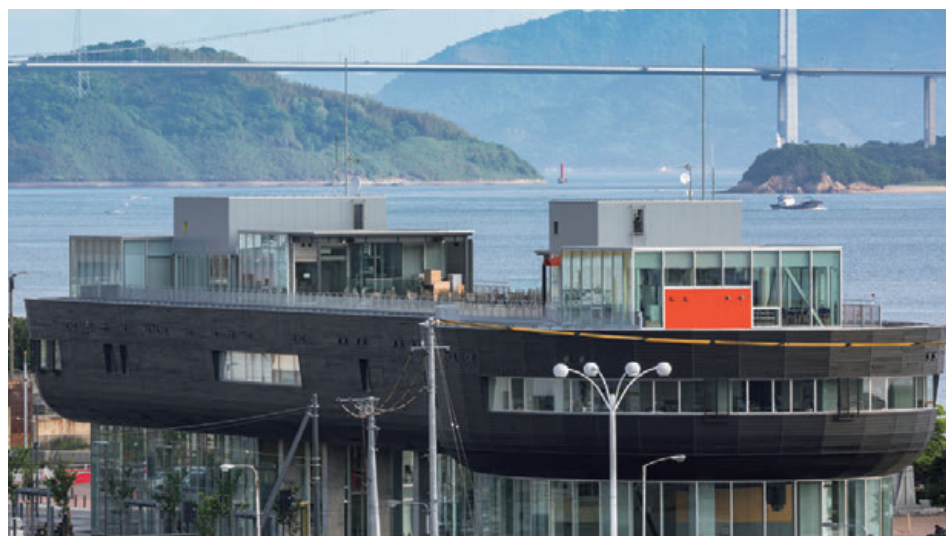
建物の外観。まるで港に停泊する大型船のような印象があります。
