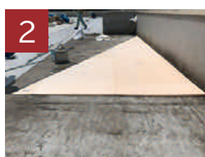
断熱材を使用した「三次元勾配断熱」で勾配を作る。
