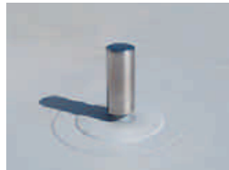
新設したAYステンレス脱気筒。
