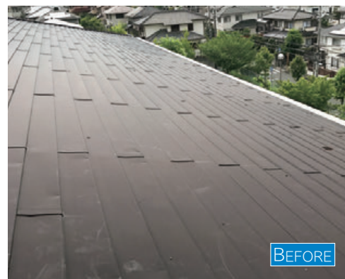
施工前の屋根。
