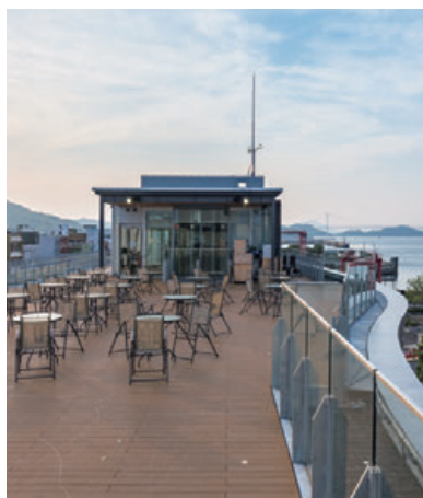
4階デッキ部分。写真奥に位置するカフェテリアの屋根がリベットルーフ防水による施工。
