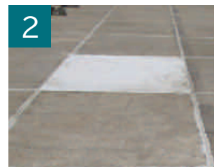
2 マス目をくり抜くように保護コンクリートの撤去を行い、モルタル金コテ仕上げを行いました。
