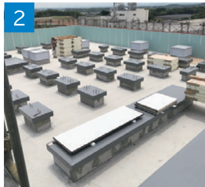
2 断熱材の敷設。
