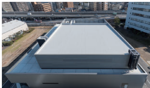
2階屋上部分は、デッキコンクリートとなっており、室外機等の大型機械が格納されています。
