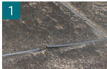
1 いたるところで既存の伸縮目地が突出していたため、全面完全撤去を行いました。
