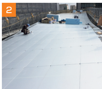
FLボードMSの設置と固定。
