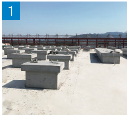
1 平場部、防水施工前。
