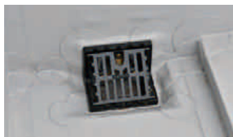
実際に設置したLCSドレン(横)。
