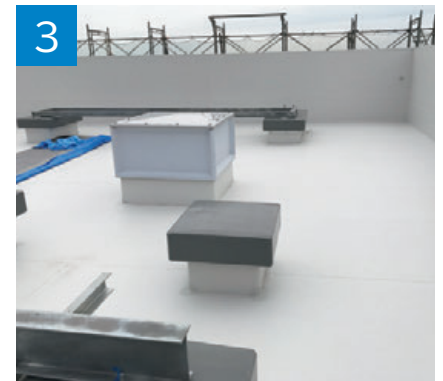
3 リベットルーフの敷き込み、固定。
