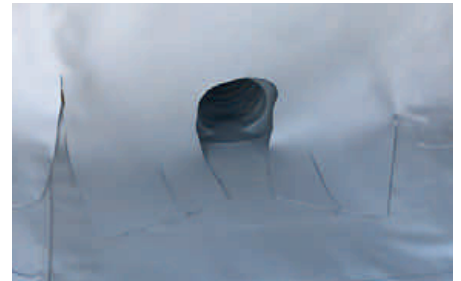
AYドレン横型を先付にて施工中の写真。
