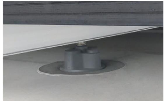
「断熱アダプター」を組み込むことで、太陽光発電システムを載せた状態でも沈み込んでいません。
