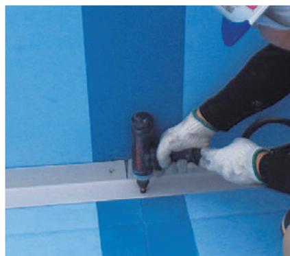
スタッド溶接機を使用し、専用のスタッドピンを下地鋼板に溶接固定するため、プール缶体に穴をあけることなく施工できます。
