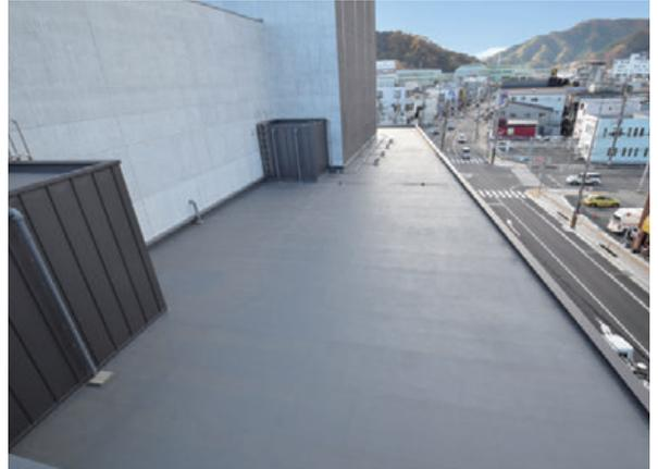
「リベットルーフHP」を用いたアンカー固定断熱工法。タラップが設置された箇所はRC造。こちらは「リベットルーフSGM」を用いたアンカー固定工法。
