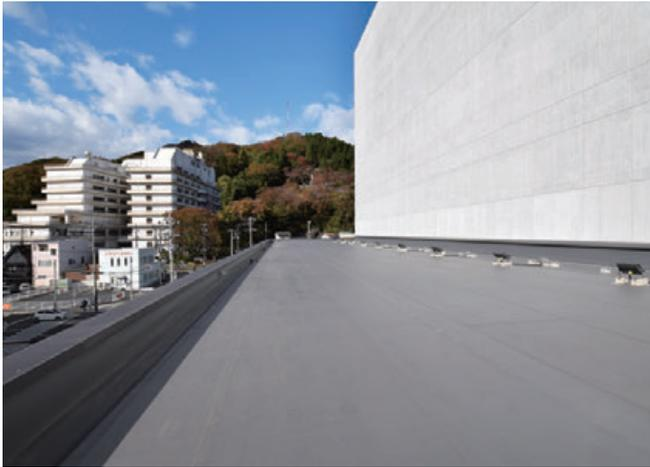
十分な横幅、深さのある側溝を設け、縦型ドレンを設置しています。
