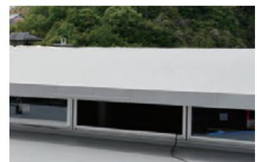
3 「AYボンド580NF」を用いた接着工法で「リベットルーフ」を納めている。
