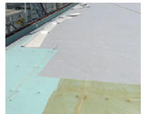
接着工法で「リベットルーフ」を施工。
