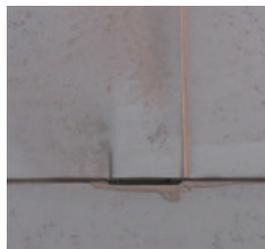
接合部の拡大写真。剥離や亀裂などが見受けられず、良好な状態。
