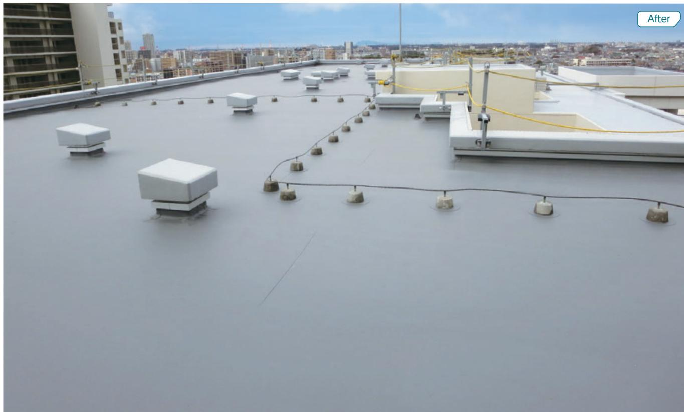
屋上面の改修後の写真。置き基礎の設置場所には増し貼りシートを施工するなどの確な対応がなされています。
