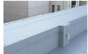
【改修後】天端部は接着工法で納めています。
