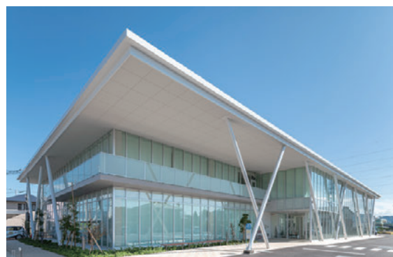
建物本体から大きく張り出した屋根底を斜め柱が支えている。
