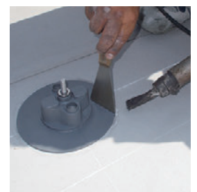
コア抜きをし、LCS断熱アダプター を設置。 リベットルーフと溶融着接合。
