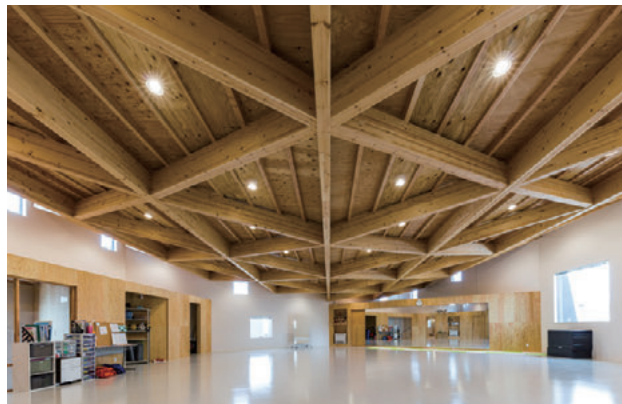
2階トレーニングスペースは広さだけでなく、天井高さも十分確保されている。
