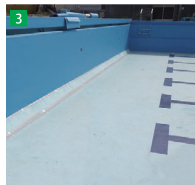
立上り部のAYプールシートG施工完了。
