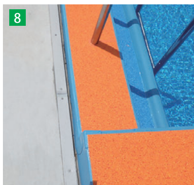
プールサイドにFL銅板を設置し、コリドールを施工。
