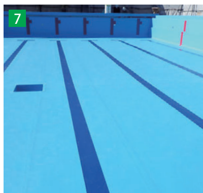
ラインテープの施工。
