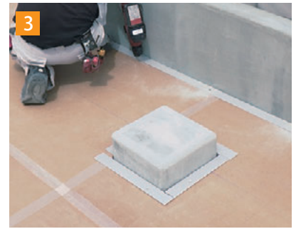
FL鋼板取り付け。
