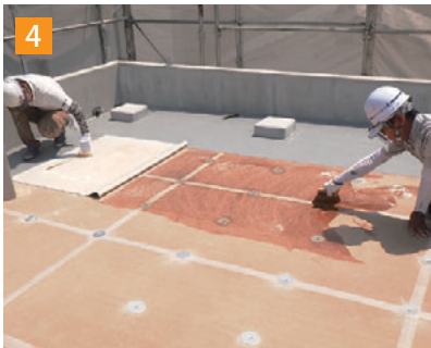
AYボンド580NF塗布、リベットルーフ敷設。
