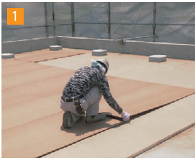
FLボードNU、AYパネルV敷設。
