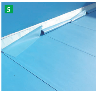
平場部のAYプールシートG張込み。
