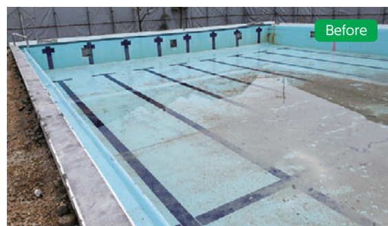
防水改修前のプール缶体。
