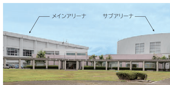
サブアリーナも、同工法で改修工事を行いました。
