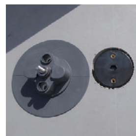
コア抜きをし、LCS断熱アダプター を設置。 リベットルーフと溶融着接合。
