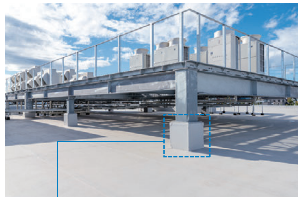
躯体に直結した鉄骨柱を基礎とする事で、重量のある設備でも屋根の上に設置する事が可能となりました。
