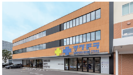
リベットルーフ「LCS工法」が採用されたビルの外観。
