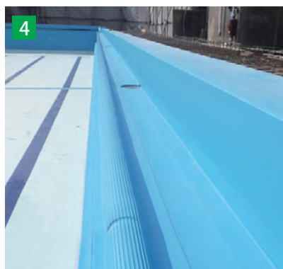
AYグリップシートの施工。
