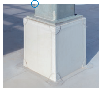
躯体に直結した鉄骨柱を基礎とする事で、重量のある設備でも屋根の上に設置する事が可能となりました。
