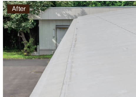
樋を撤去した後、耐水合板を下地として、リベットルーフで防水処理を行った。
