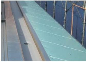
鉄骨母屋に対してFLボードNPを直接固定。
