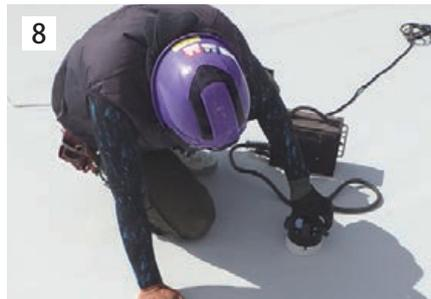
8 IH断熱ディスクの誘導加熱接合。
