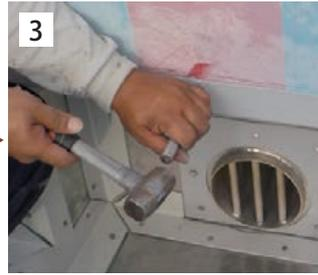
3 ピン頭部を叩く。(ピンを丸く変形させて、取付物のガタツキを無くす。)
