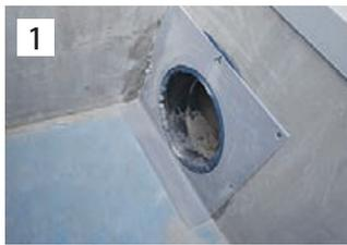
1 排水溝に硬質塩ビ板を取り付け。
