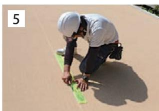
5 突付け部にV字型の溝を掘る。
