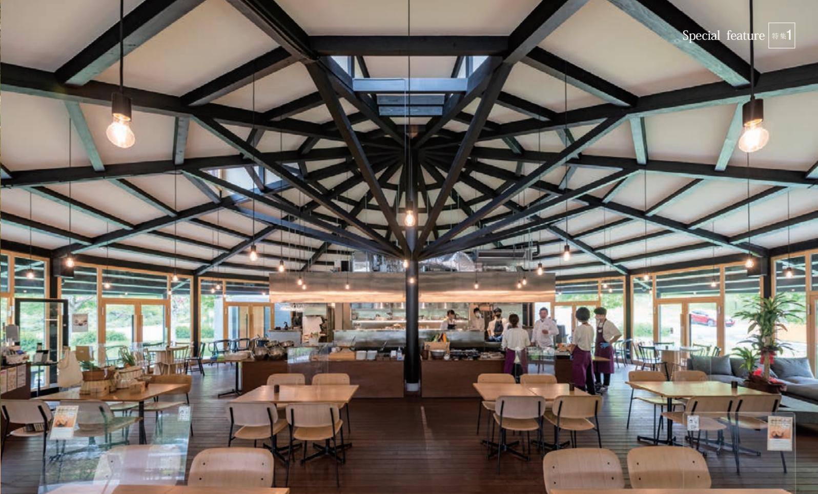
レストラン棟の店内の様子。店内の中心には1本の柱が立てられており、傘を開いたように梁が外に向かってのびる。根太のピッチはリベットルーフを確実に固定できるように打ち合わせで決定した。
