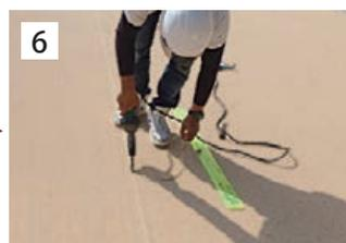
6 床溶接棒を熱溶接。
