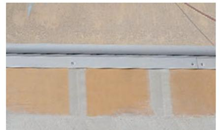
複雑な形の手掛部をFLステンレス鋼板で覆う事でAYプールシートGを確実に固定しています。
