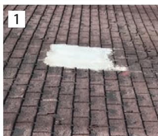
1 屋根の一部をモルタル補修・下地調整。
