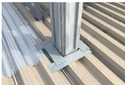
鉄骨柱にあらかじめ溶接したC型鋼に対して、耐火野地板を固定しました。
