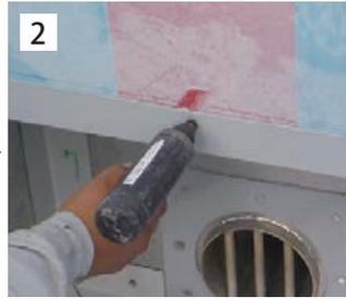
2 スタッド溶接でFLステンレス鋼板を固定。
