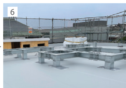
平場部の施工完了。
