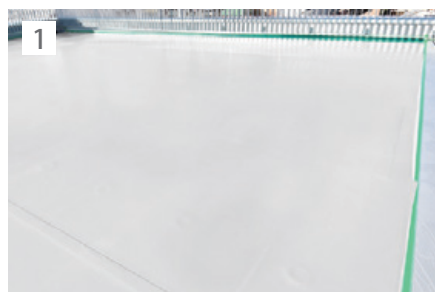
1 外周部の養生を行い、AYプライマーReを塗布。
