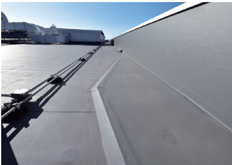
加工した断熱材を設置して水はけを向上。
