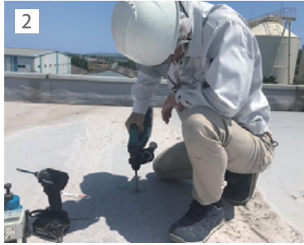
2 現場調査と引き抜き試験。
