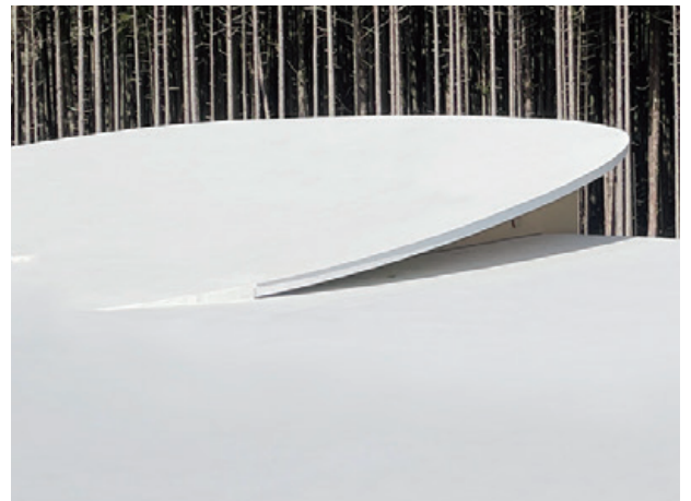
シートをAYボンド580NFで接着、端部を溶融着してカーブする軒が完成。
