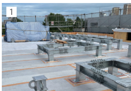
断熱材設置前の状況。
