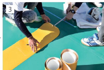
3 文字パーツを組み合わせて、AY反射フィルムを仮留めます。
