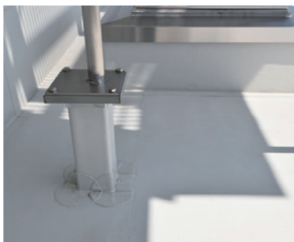
柵の基礎部分
