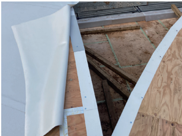
シート施工前。水切り金物の上にFL鋼板を重ねて設置しています。
