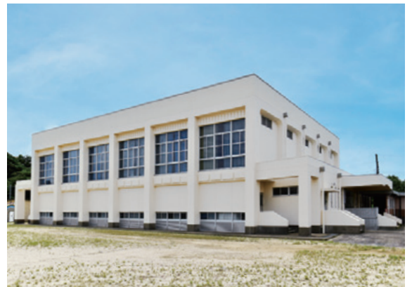
体育館の外観。
