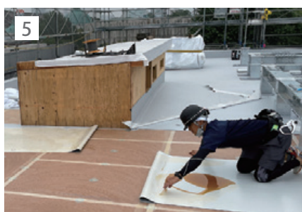
接着剤塗布(リベツトルーフ裏面)と貼り込み。
