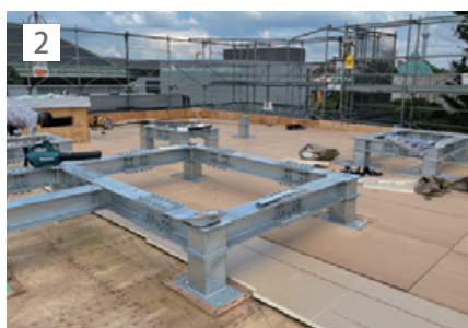
断熱材、AYパネルVの設置。
