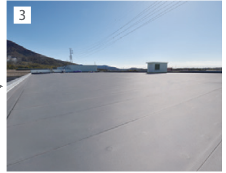
3 防水改修実施。
