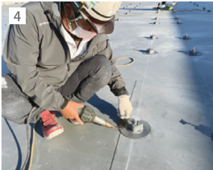
4 太陽光基礎設置。
