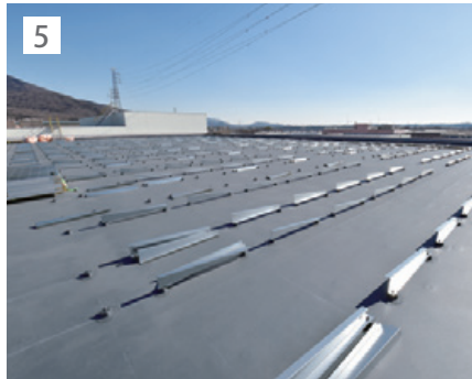
5 傾斜付き架台とモジュール設置。
