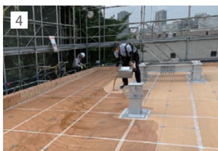
接着剤塗布(下地側)。
