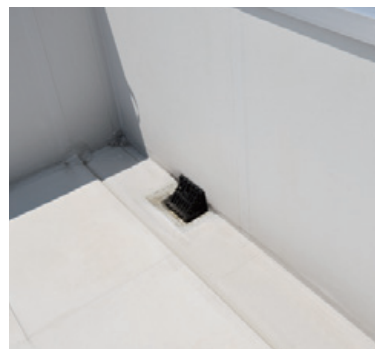
塔屋側溝のドレン
